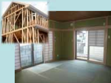
■ 柱や梁で構造を支える在来工法
