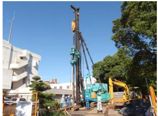
丸太打設状況
