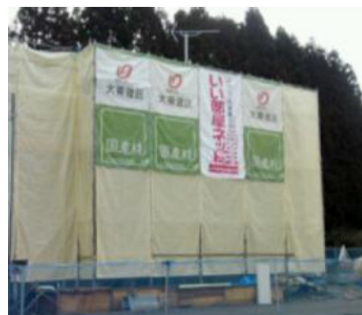
工事仮設養生シート (大東建託(株))
