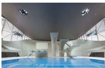
水泳競技施設（天井に使用）
