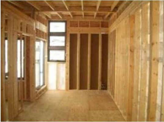
構造材（集成材）の一部に国産スギを採用
