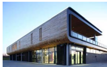
カヌー競技場（内外壁、床、天井に使用）
