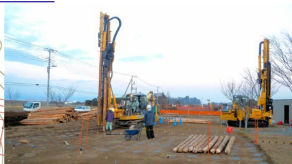
丸太打設状況
