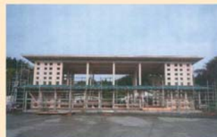
事務所棟(福島県いわき市)
