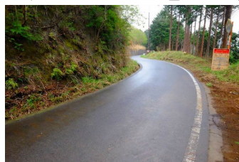
① 30年以上経過しても健全なアスファルト舗装
