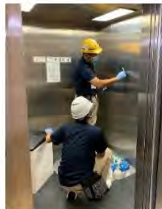
EV抗菌施工
