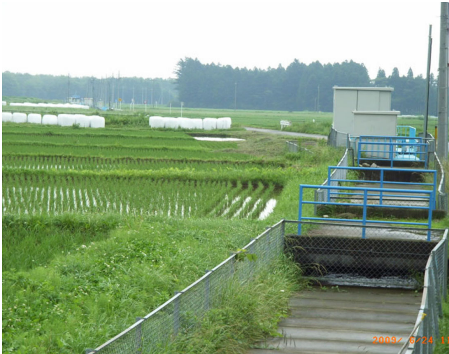
農業用水を利用した小水力発電
