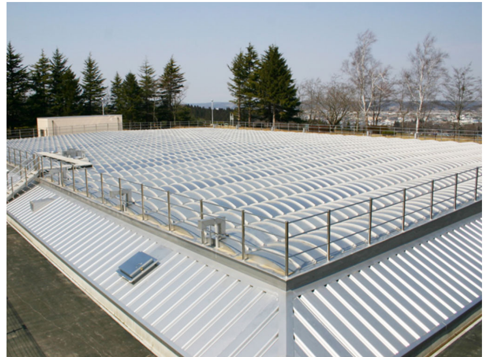
水道用水を利用した小水力発電
