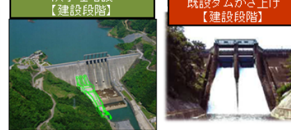
早明浦ダム(高知県) 洪水吐増設 【建設段階】
