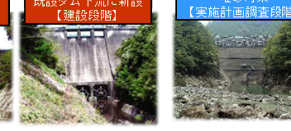
五名ダム(香川県) 既設ダム下流に新設 【建設段階】
