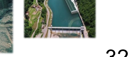
千五沢ダム(福岡県) 洪水吐改造 【建設段階】
