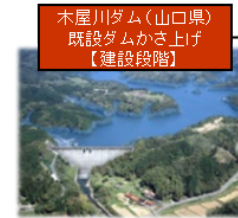
木屋川ダム(山口県) 既設ダムかさ上げ 【建設段階】
