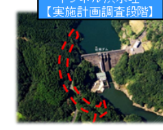
岩瀬ダム(宮崎県) トンネル洪水吐 【実施計画調査段階】
