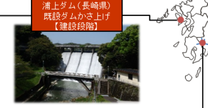
浦上ダム(長崎県) 既設ダムかさ上げ 【建設段階】
