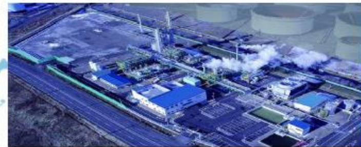
苫小牧CCS実証試験センター
