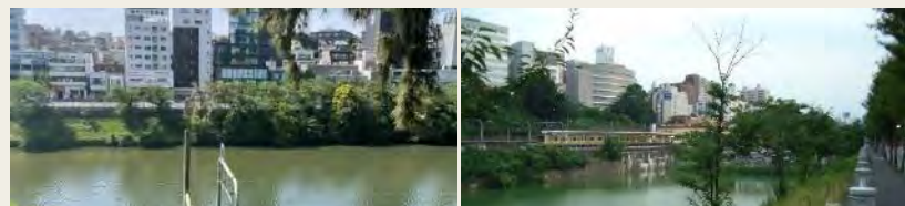
護岸の高さによる街との分断
