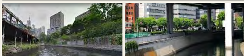
護岸の高さによる街との分断
