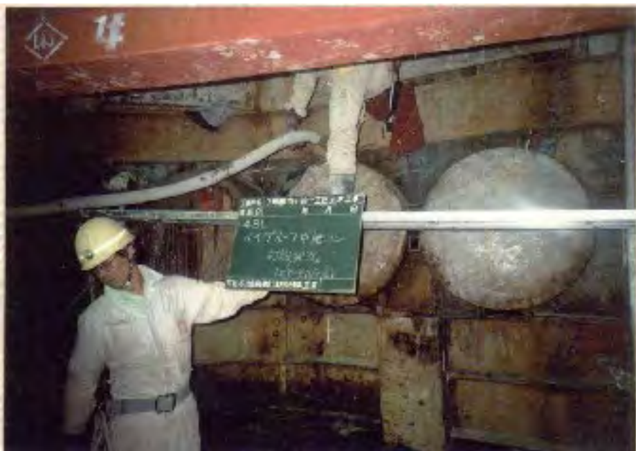
パイプルーフ中詰コンクリート打設
