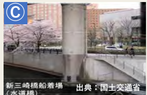
新三崎橋防災船着場
