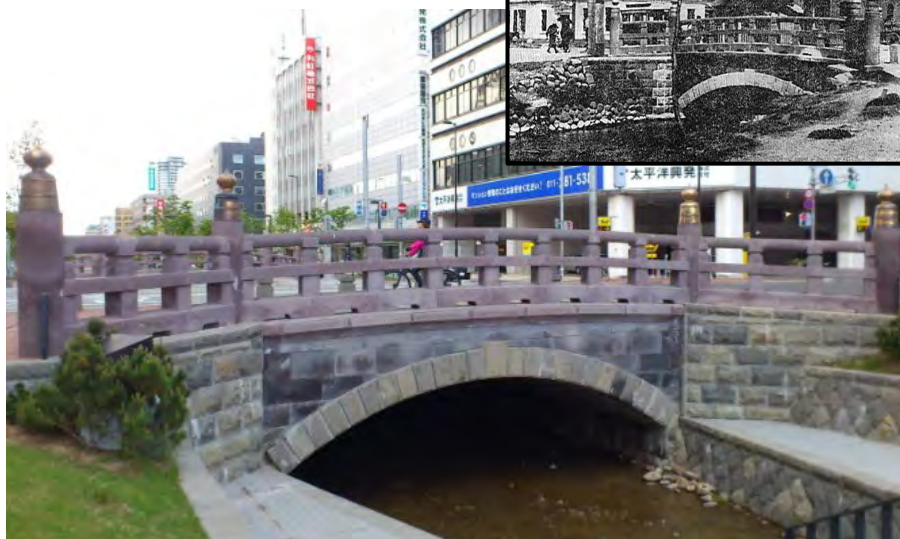
明治43年に架橋された創成橋を復元
