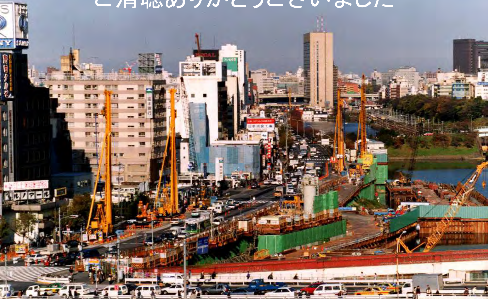
市ヶ谷駅建設工事全景
