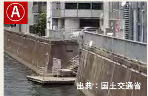
市兵衛河岸防災船着場
