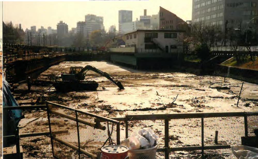
写真: バックホウによるしゅんせつ状況
