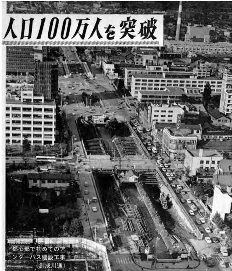
昭和45年の広報さっぽろアンダーパス工事の写真
