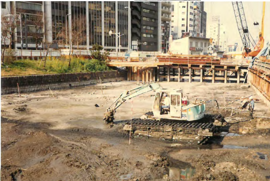
写真: バックホウによるしゅんせつ状況
