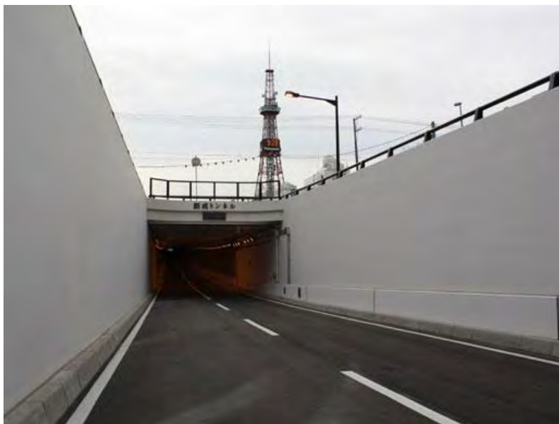
トンネル入口
