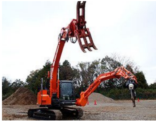
解体・積込自動化
