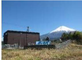
本門寺第一発電所
