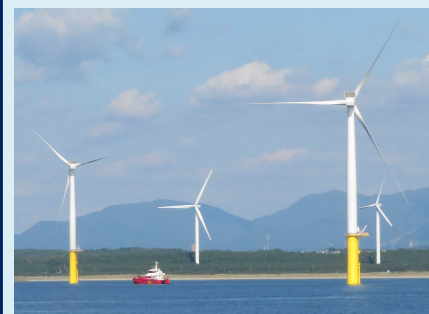
秋田港内洋上風力発電事業
