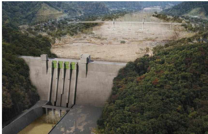
試験湛水中のハッ場ダムが洪水を貯留 （実写を画像化）
