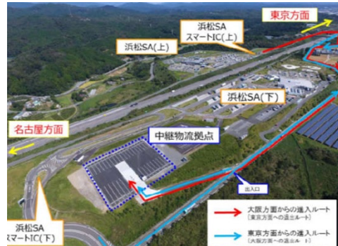
出典:中日本高速道路株式会社資料より引用
