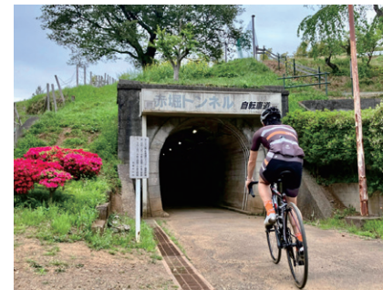
本線脇の自転車専用トンネルの例
