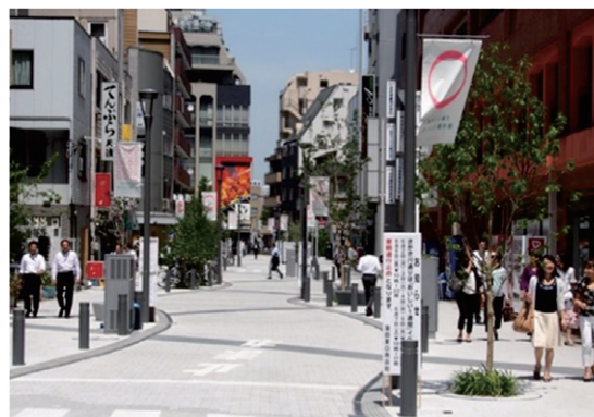
道路空間の再整備例（大田区・さかさ川通り）
